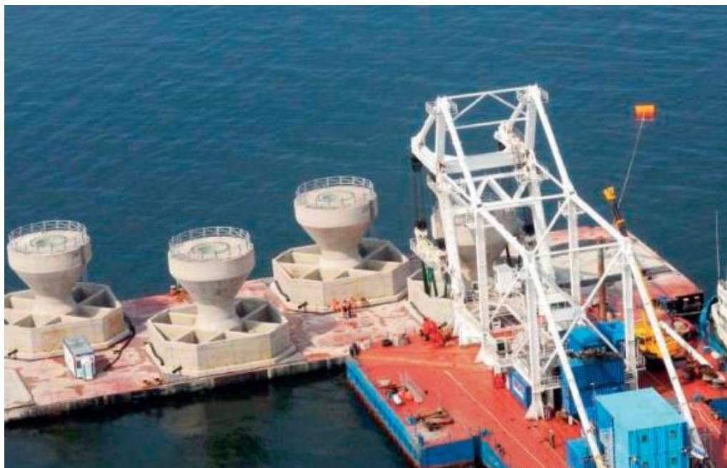
Figur 5.4.4 Gravitationsfundamenter placeres på havbunden. Billede fra Rødsand II. (kilde: www.aarsleff.dk )
