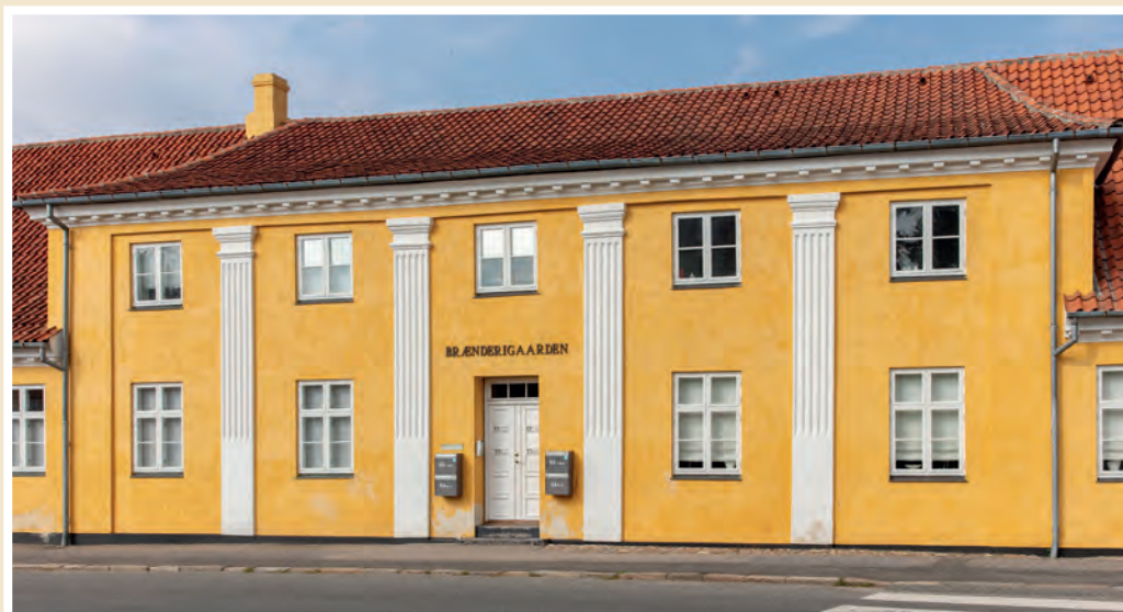
En pilaster er et fladt søjlerelief på muren, med kapitæl og evt. base. Brænderigården i Slagelse.
