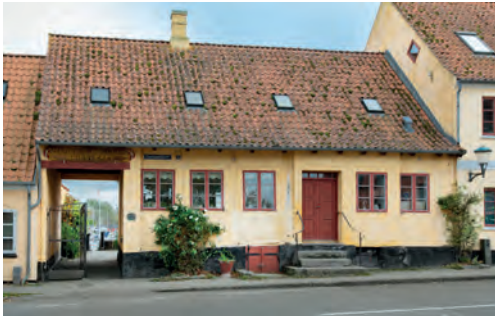
Gammeltovej 1A, Skælskør. Opført 1744. Bevarings- værdi 2.
