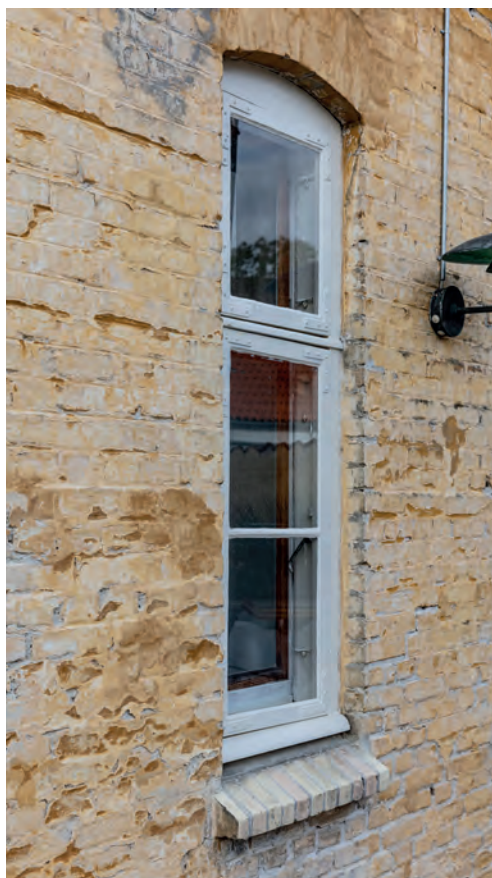
I overensstemmelse med alle gode råd om vedligeholdelse af gammelt træværk er de originale vinduer malet med linoliemaling.
