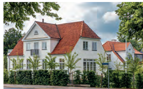
Villaen på Slotsalléen 20 i Slagelse, er et eksempel på den enkle, nyklassicistiske stil med frontispice, gesimser og småsprossede vinduer. Halvvalmet tag med røde tegl.
