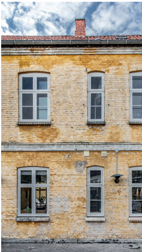
Et bevaringsværdigt byhus i Skælskør (SAVE 3) får rensset murværket for gammelt puds, kalkflager og porøse fuger. Bagefter skal fugerne fyldes med ny kalkmørtel – en skrabeuge – og murværket skal pudses og kalkes igen.
