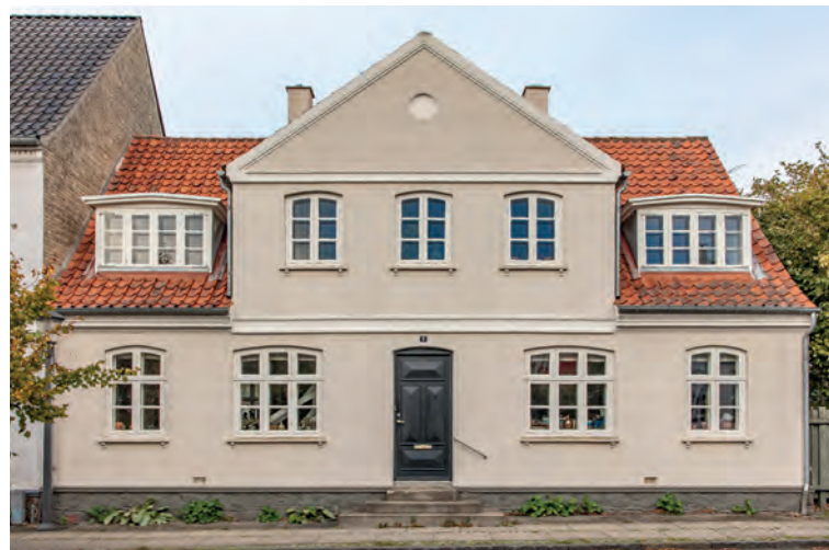
Skovvej 8, Skælskør. Opført 1905. SAVE 3
