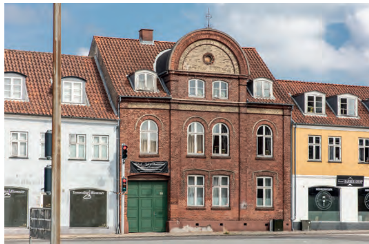
Jernbanegade 18, Slagelse. Opført 1900. SAVE 4
