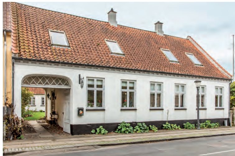
Skovvej 5, Skælskør. Opført 1930. SAVE 3
